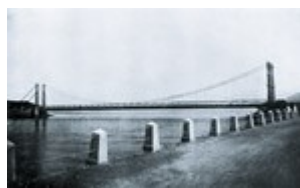
Figura 2- Construção da Ponte Pênsil em 1914. Fonte: www.praiagrande.sp.gov.br
