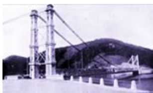
Figura 1- Construção da Ponte Pênsil em 1914 Fonte: www.praiagrande.sp.gov.br
