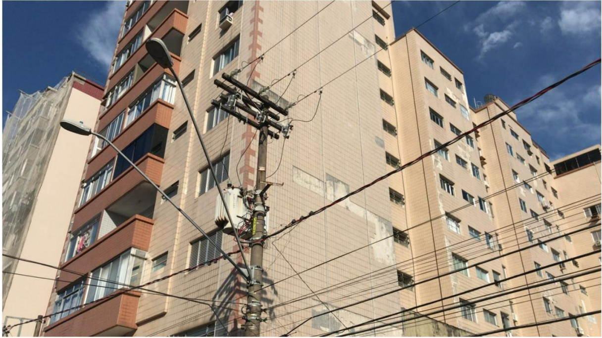
Fachada lateral - Figura 6
