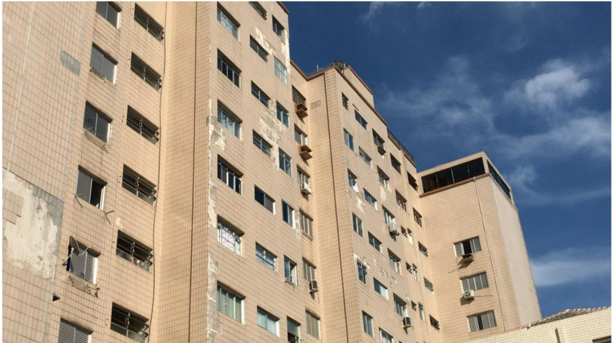
Fachada lateral - Figura 5
