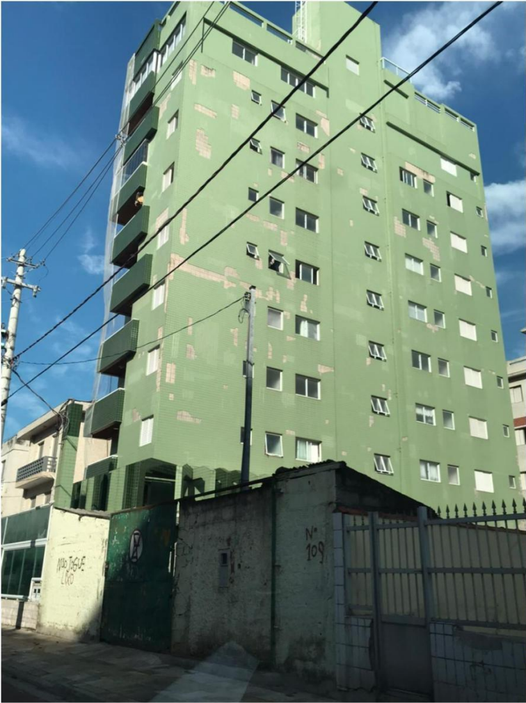
Fachada lateral - Figura 7
