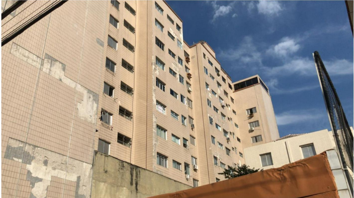
Fachada lateral - Figura 4
